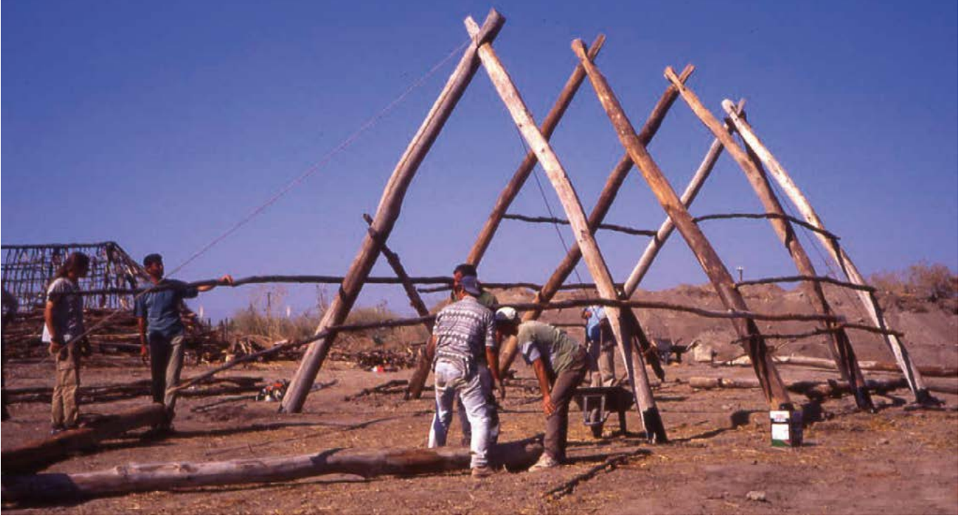
Figür 7. Aşağı Pinar Açık Hava Müzesinde iğmeli samanlıkların sergi evi olarak kurulma süreci
